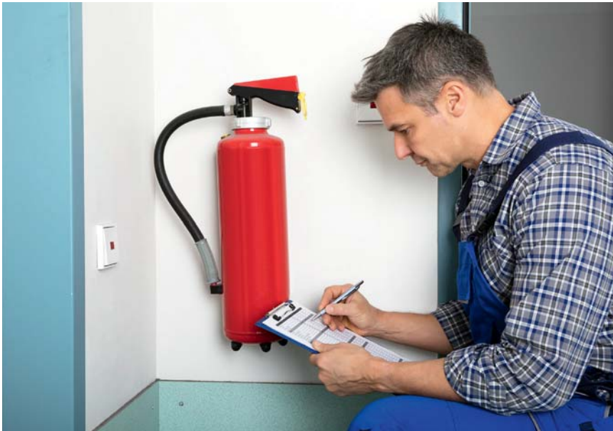
Les extincteurs doivent être révisés régulièrement.
