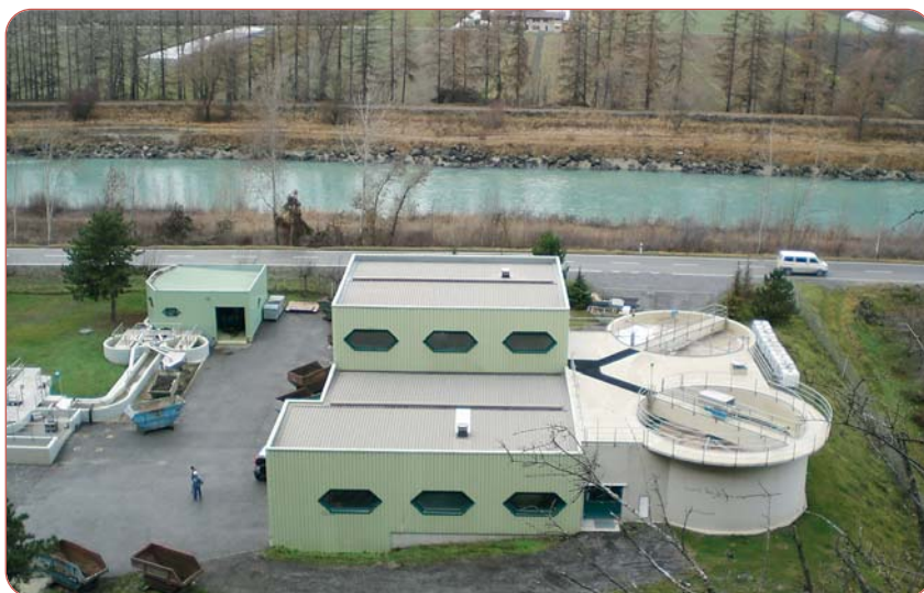
Vue sur la station de prétraitement des eaux provenant d'Aproz Sources Minérales SA.
