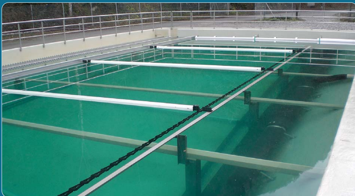
Bassin en fin de chantier, rempli d'eau claire.
