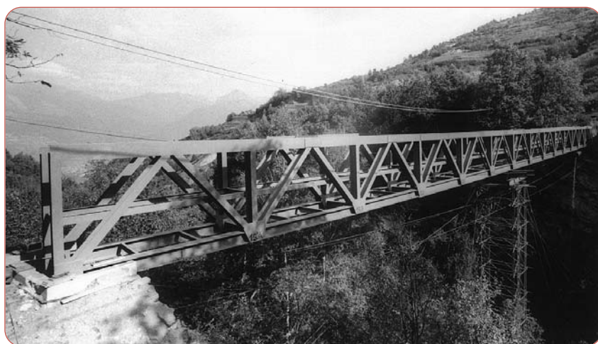
La passerelle permettant aux égouts de la rive droite de franchir la Printse, lors de sa construction en 1986.
