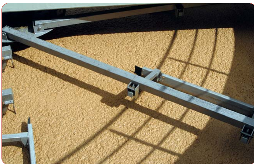
Boues biologiques du prétraitement.
