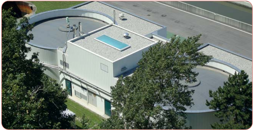
Les «digesteurs» pour les boues; avec dans le bâtiment central la nouvelle turbine à gaz.
