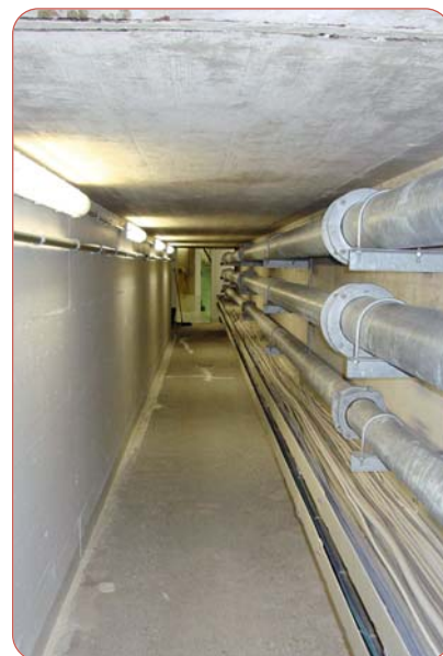
Vue souterraine très partielle.
