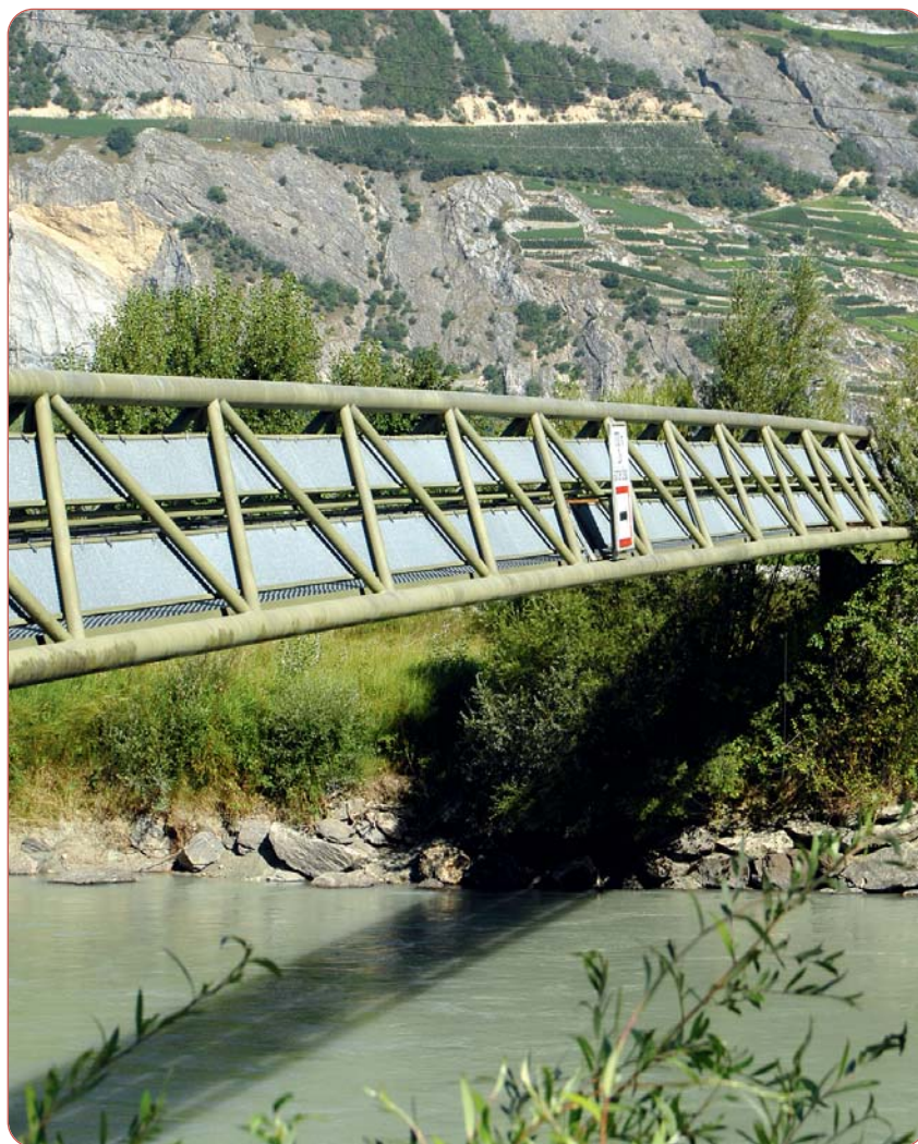
Franchissement du Rhône par les égouts d'Ardon, en direction de Bieudron.
