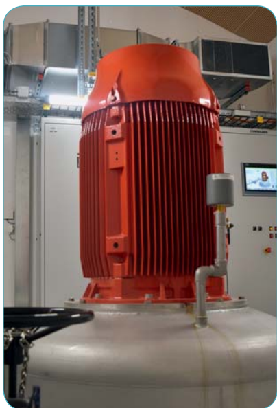
Les turbines ont été installées au-dessus de réservoirs d'eau existants.
