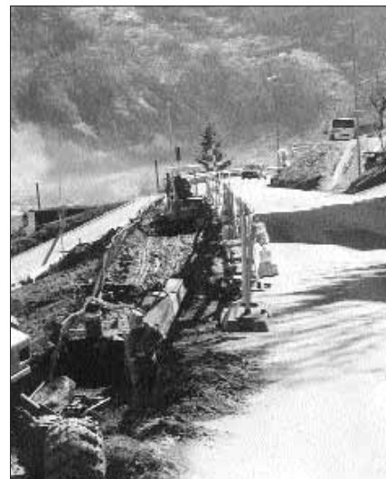
Correction de la route Sion-Nendaz, tronçon ouest de Basse-Nendaz.
