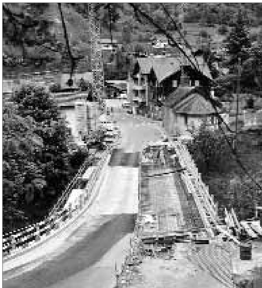
l'enrobé et les finitions. Pendant les travaux la circulation se fait en alternance, sur une piste, avec signalisation de régulation.
