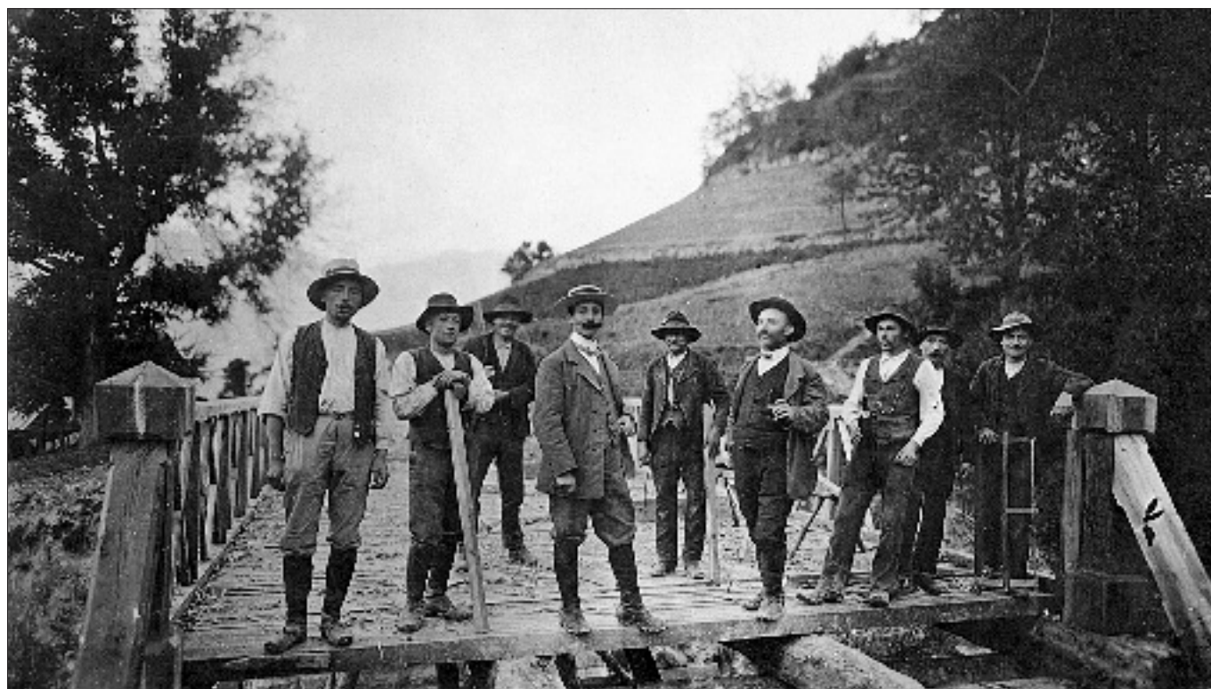
Construction de la routes Sion-Nendaz : en 1913, franchissement de l'Ogeintse, à Beuson.
