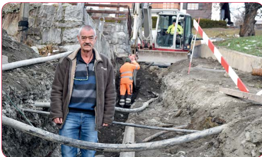
Pierre Lambiel sur un chantier communal. © Sonia Déléze
